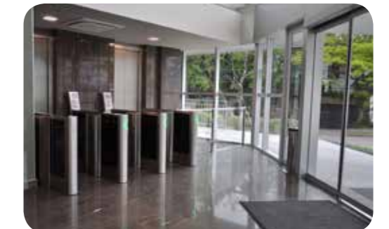
Bloqueio dGate instalado em um edifício comercial em Porto Alegre, Rio Grande do Sul.
